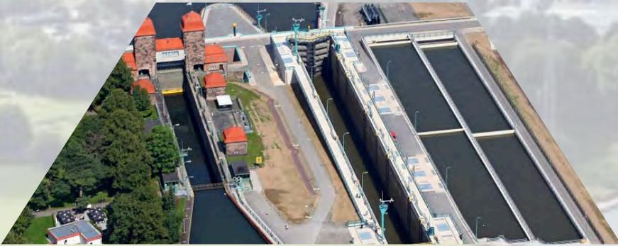
Die Kammer der Schachtschleuse, in der die Schiffe vom Kanal zur Weser abgesenkt beziehungsweise von der 13 Meter tiefer liegenden Weser zum Kanal gehoben wurden, ist 85 Meter lang und 10 Meter breit. Etwa sieben Minuten dauerte die Schleusung eines Schiffes. Im Vergleich dazu: Die Kammer der neuen Weserschleuse ist immerhin 139 Meter lang und 12,50 Meter breit.
